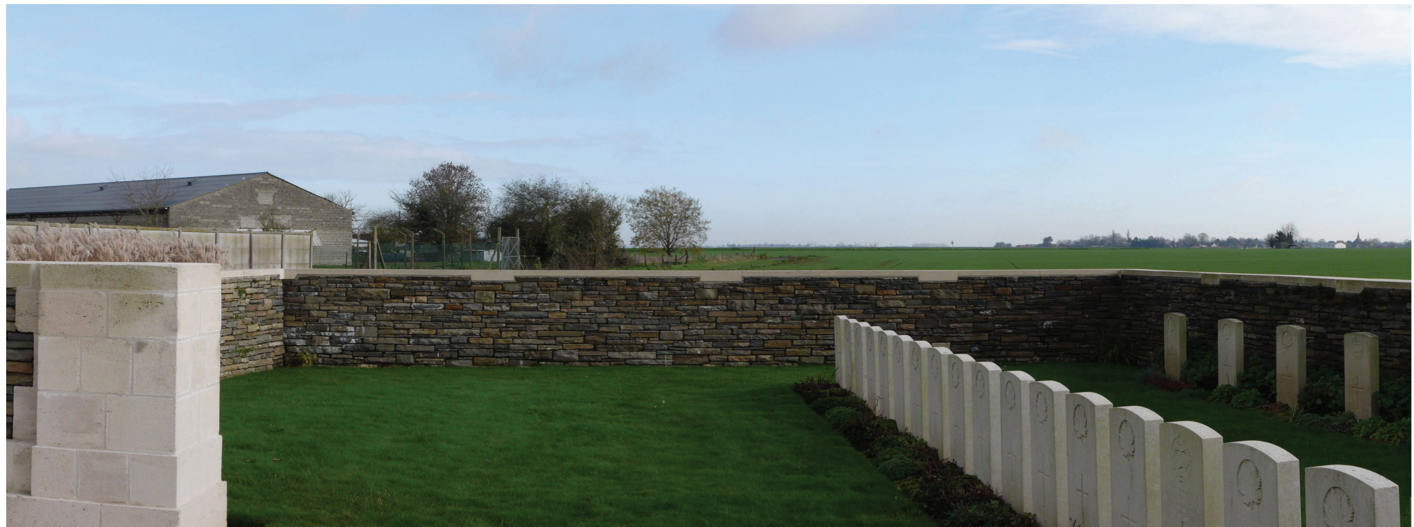
Photographie état initial - panorama à 60°
